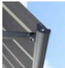
Smal arm med Design frontprofil. Alltid utan kapp
